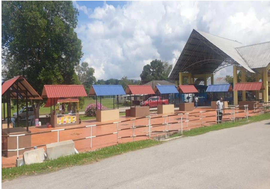
Pandangan sisi kiri tapak yang akan dipasang bumbung
